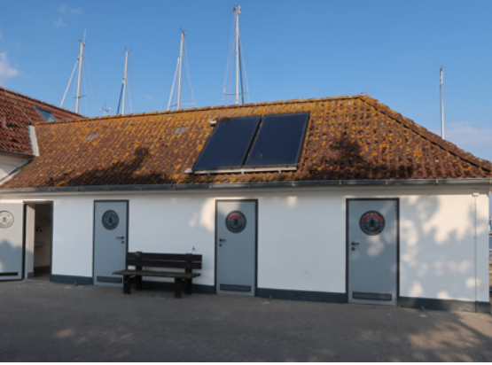
... die sanitären Anlagen sind erneuert (Fotos Birgit Güldener)
