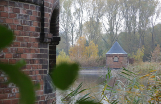
Becken der Langsandsfiltration und Schieberhäuschen
