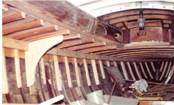
Eine Planke aufgesetzt, verbreitert, Deck neu verlegt
