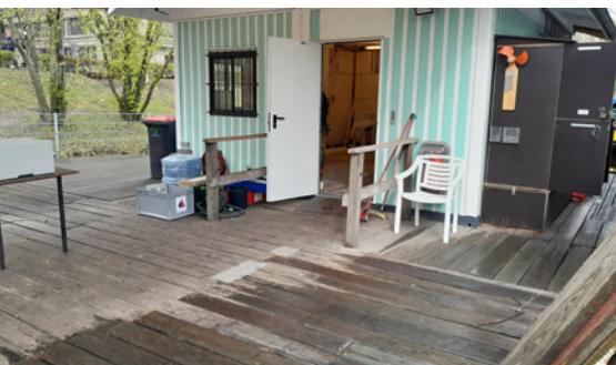
Während der Arbeiten
